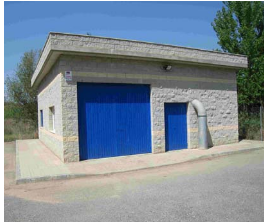
ESTACIÓN DE BOMBEO A DEPURADORA EXISTENTE
